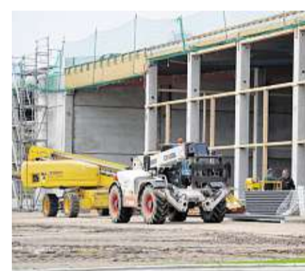
Die ersten Bagger rollen bereits am Bosteler Feld
